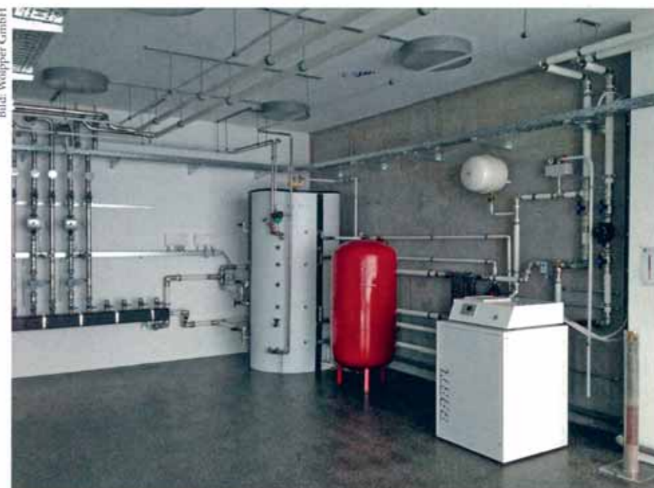
Ebenso durchdacht wie das Gebäude mutet der Technikraum an. Rechts im Vordergrund ist eine Gesteinsprobe der Bohrungen für die Erdsonden zu sehen. Ein Hygienespeicher mit Edelstahl-Wellrohrwärmeübertrager liefert im Durchlaufprinzip warmes Wasser. Die Sole-Wärmepumpe von Bartl wird in Verbindung mit einer Freikühlung mit Erdwärmesonden betrieben und versorgt Fußbodenheizung, Betonkernaktivierung, Wärmeübertrager des Lüftungssystems und einen Hygienespeicher für die Warmwasserversorgung.
