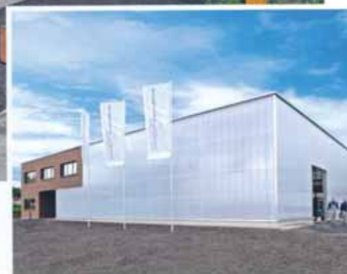
Die außergewöhnliche Fassade aus Polycarbonat-Paneelen zeigt sich dank ihrer ästhetischen Optik und ihrer Energieeffizienz im doppelten Sinn funktional.
